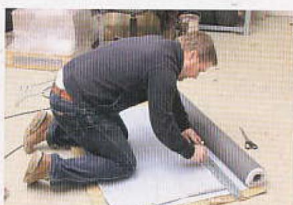
...aus der Dämmmatte schneidet. In der Regel lassen sie sich mit Teppichmesser und Tapetenschere schneiden, ein Regalwinkel...
