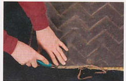
Möglichkeit zwei: Filz ohne Kleberücken. Mit der alten Matte als Schablone kann man ein exakt passendes Stück zurechtschneiden
