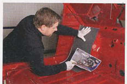
Wer vorher auch noch von vermeintlichen Kleinigkeiten wie der Dämmung Fotos macht, erleichtert sich die Arbeit erheblich
