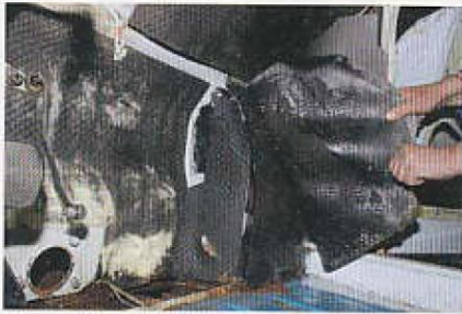
Und tschüss: Alte Dämmmaterialien sollten vorsichtig entfernt werden, einige enthalten gesundheitsgefährdende Stoffe
