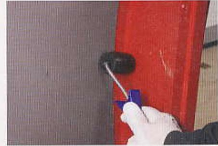
In diesen Bereichen muss der Kleberücken Schwerarbeit leisten. Ein Tapetenandrücker leistet bei der Montage gute Dienste
